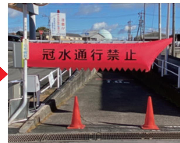
集中豪雨の被害を受けて、冠水中に車があやまって侵入しないように、バールン式の交通遮断機を設置。写真提供：一宮市
