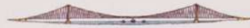
世界最長のつり橋 イギリスのハンバー橋は、開通した1981年当時、世界最長のつり橋だった。
