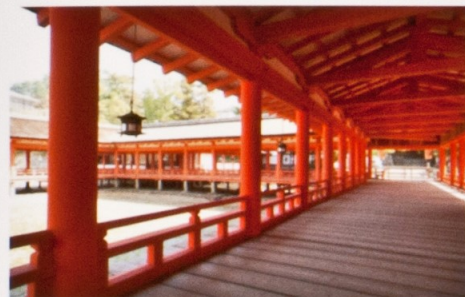
国宝に指定されている回廊。幅は4mほど、総延長は275mほどあり、床板の間のすき間が、高潮のときに下から押し上がってくる海水の圧力を弱め、海水や雨水を海へ流す役割を果たしている。
