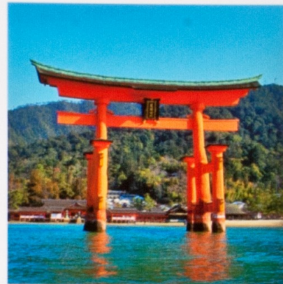
重要文化財に指定されている、高さ16mほどの厳島神社大鳥居。大鳥居は、根元が海底にうめられていないものの、松の木の杭を打って地盤を強化し、柱と柱の上にわたされた箱型の島木の中に石をつめて重さを増すなどして、約60トンの総重量だけで立っている。
